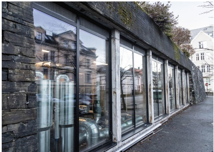
Den utvendig aluminiumsfasaden ved Realfagbygget på Universitetet i Bergen har fått trelags glass.
