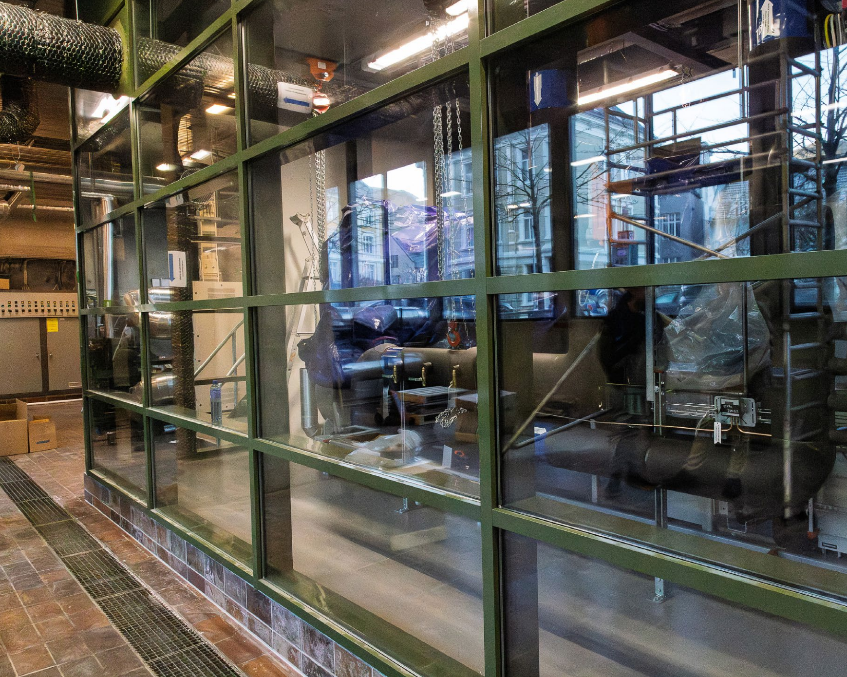
Varmesentralen ligger i underetasjen av bygget. Her er to utsatte rom innkapslet med en glassfasade. Begge med brannhemmende glass. Rommet med varmepumper har i tillegg fått støydempende glass.
