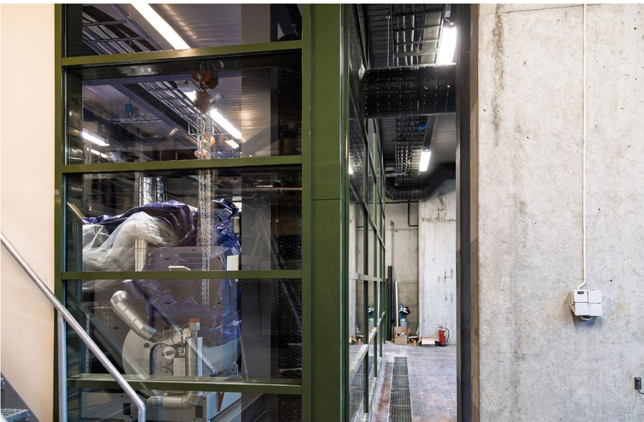
Varmesentralen ligger i underetasjen av bygget. Her er to utsatte rom innkapslet med en glassfasade. Begge med brannhemmende glass. Rommet med varmepumper har i tillegg fått støydempende glass.
