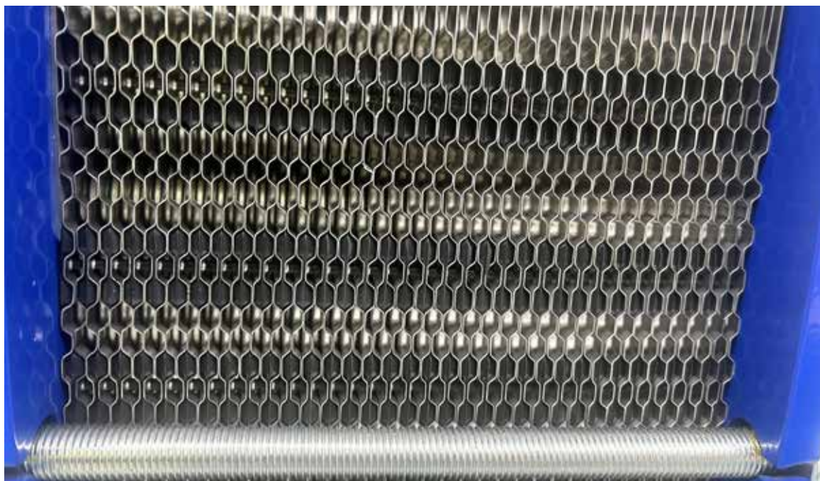
Sjøvannet og glykolen rører ikke hverandre. Veksleren på bildet er av rustfritt stål.
