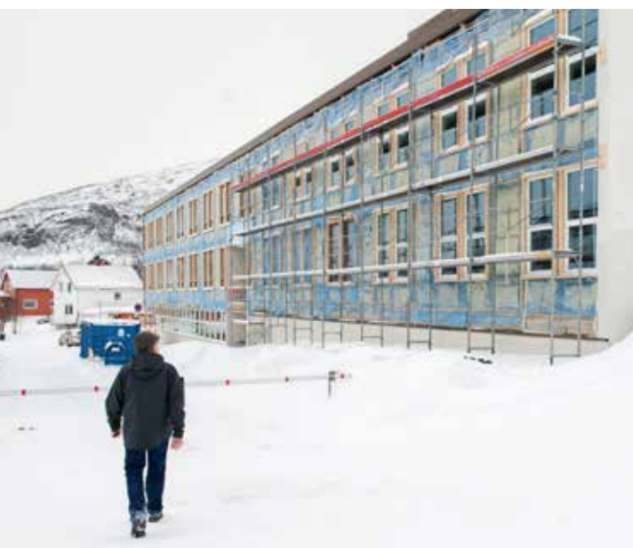
Enova har gjennom mange år gitt støtte til energieffektivisering, uten at markedet har tatt helt av. Bildet er fra et Enova-støttet oppgraderingsprosjekt i Skjervøy kommune i Troms.
