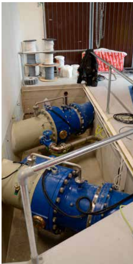
◀ Eikemo kraftverk har et splittet turbininntak, synlig i hovedrommet.
