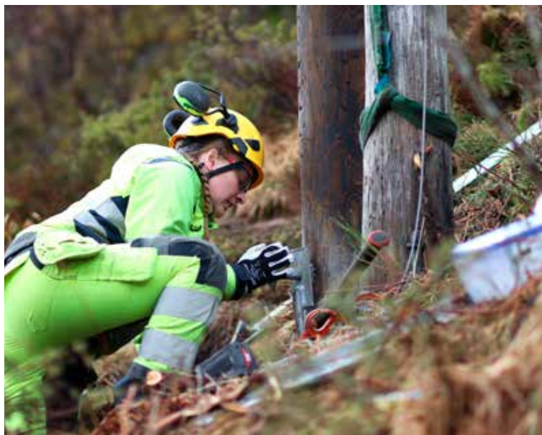
Denne dagen skal en ny stolpe i lavspennettet heises opp.
