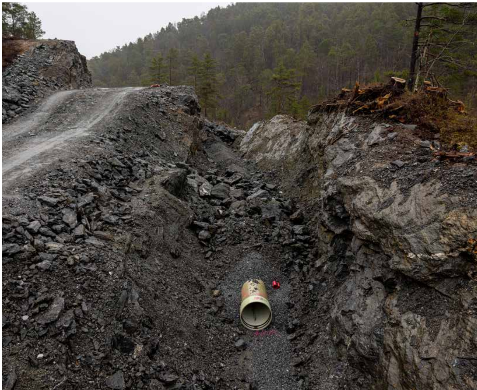
Røret ved inntaket er klart for vannfylling om et par uker.
