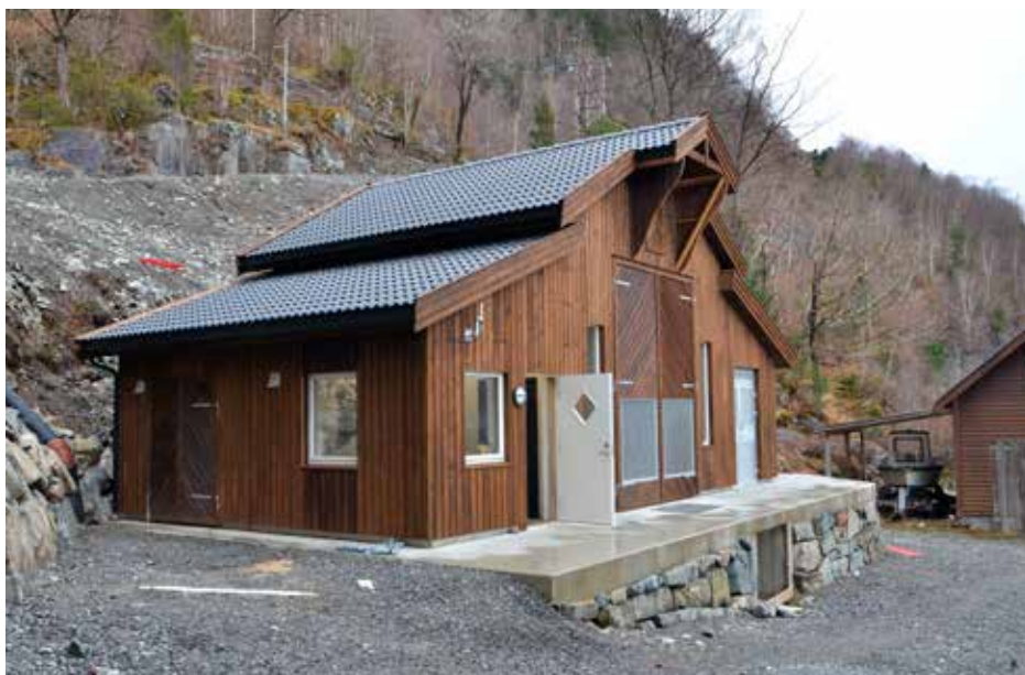
Djuvselva kraftverk er tegnet med stor dobbeltdør og inspirasjon fra klassiske handelshus på Vestlandet.
