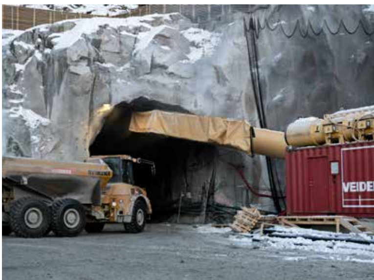
Kraftverket måtte flyttes da Statnett endret sine utbyggingsplaner. Her fra tunnelinnslag til Feios kraftverk, som skal ligge inn i fjellet. Foto: Vidar Stadheim
