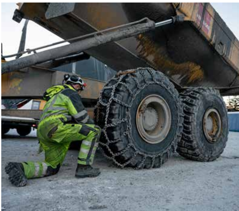
Det er store dimensjoner og mye stein som skal ut for å lage vannmagasin inne i fjellet. Foto: Vidar Stadheim
