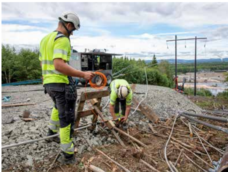
Olsen er også styreleder i Norges suverente største nettselskap, Elvia. Bildet viser ansatte som forbereder sprengskjøt for å koble sammen de nye linjene over til Braskereidfoss kraftverk etter damkollapsen i fjor. Foto: Erik Thallaug
