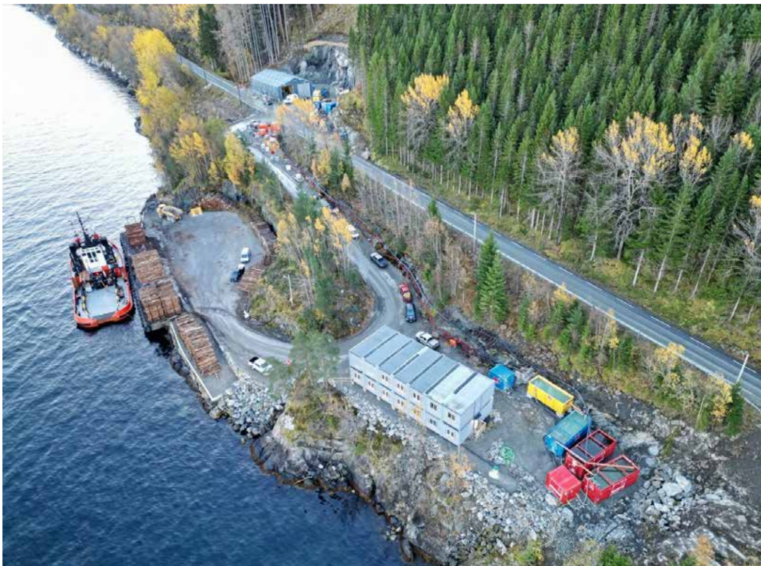
Tunnelinnslag og brakkerigg på Håastrondi ved Sognefjorden. Vannet fra kraftverket vil renne ut i fjorden litt høyre for bildet. Sognekraft arbeider for å få brukt riggområdet til et samfunnsnyttig formål når byggearbeidene er avsluttet. Foto: Sognekraft
