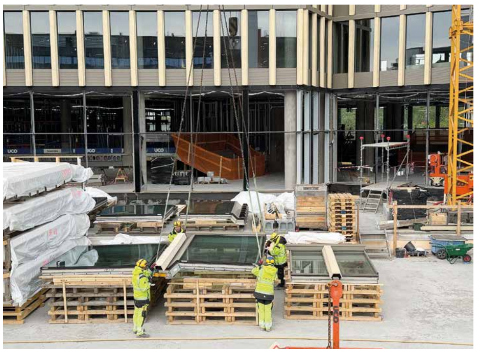
Fasadeelementene leveres puljevis til byggeplassen og ligger ikke lenge før de heises opp og inn i bygget.
