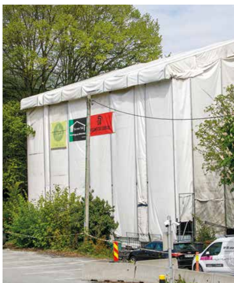
Rehabiliteringsarbeidet foregår under tak-over-tak.
