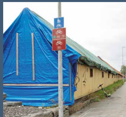
Den fredede reperi langs Fjøsangerveien skal renoveres. Her er Årstad Bygg spente på hvilke løsninger som skal brukes på fasadene.
