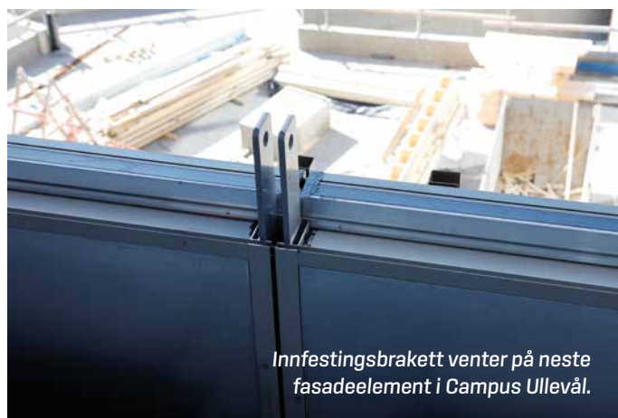
Innfestingen er forberedt med braketter i bæresystemet, og betongbjelker er senket i forkant for å håndtere toleranser.
