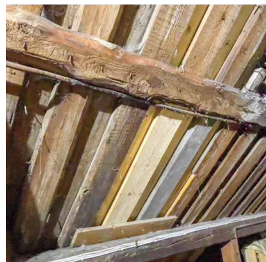
Råttent treverk i sutaket er erstattet med ny plank i kjerneved av furu. Byggmester Tjensvoll produserer slik plank selv.
