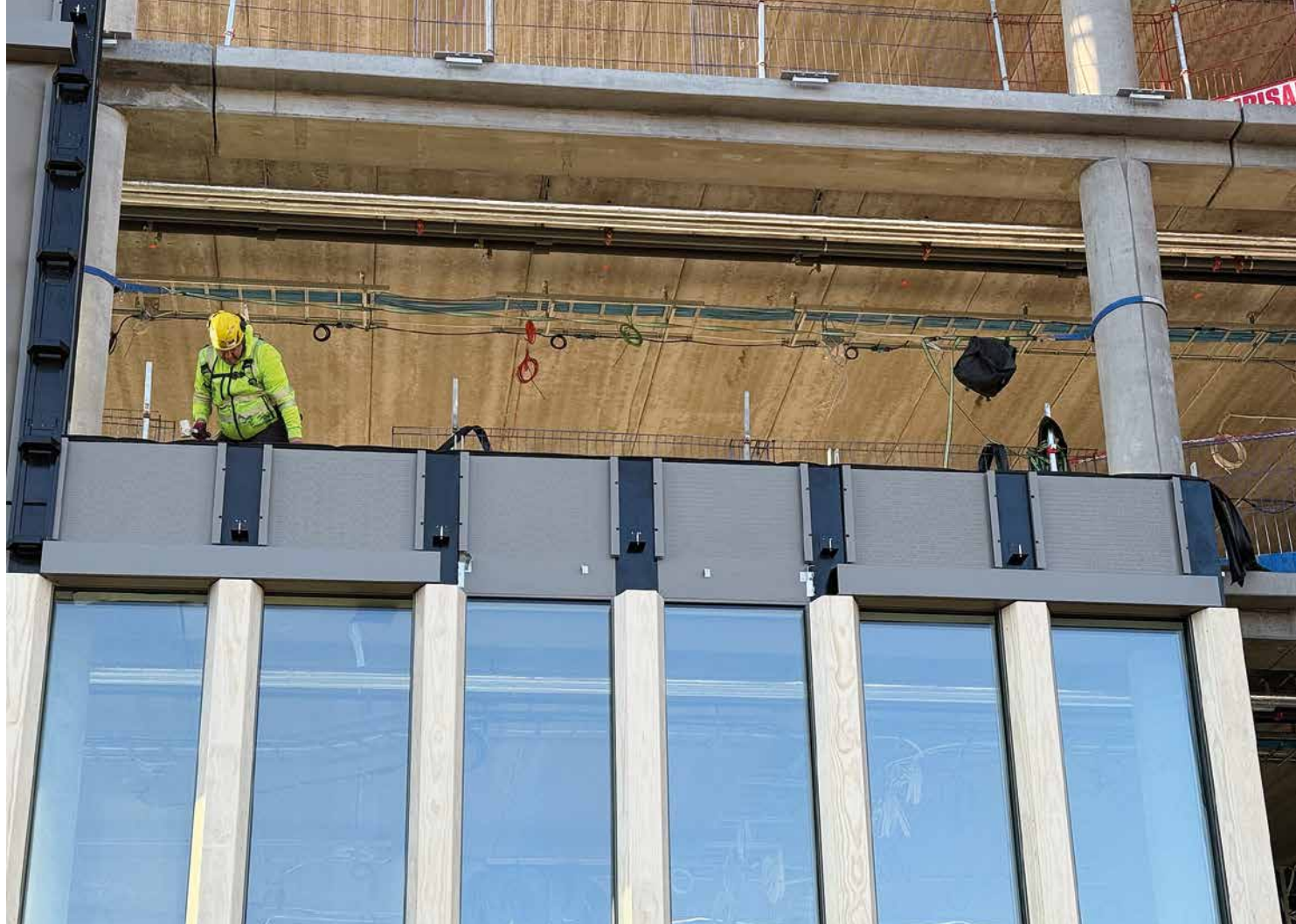
Innfestingen er forberedt med braketter i bæresystemet, og betongbjelker er senket i forkant for å håndtere toleranser.
