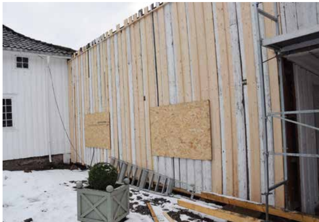
GJENBRUK: Gammel og ny kledning på veggen. Det har vært et poeng å gjenbruke mest mulig av de gamle kledningsborda.
