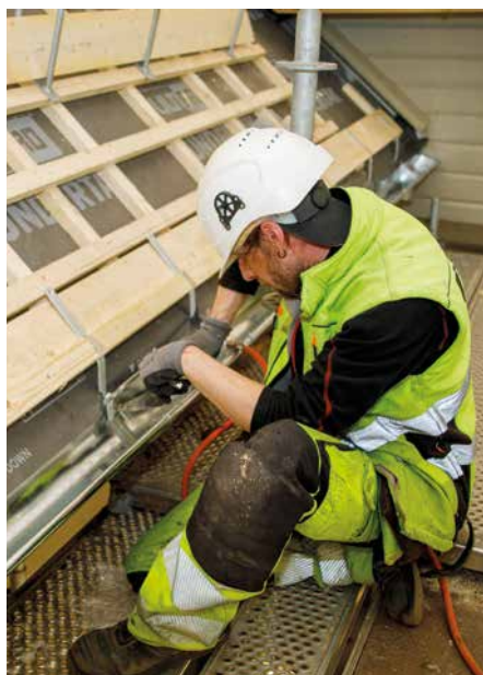
Blikkenslager Marcin Andrzejak i Blikk Teknikk AS, lodder skjøt til takrenna i sink.
