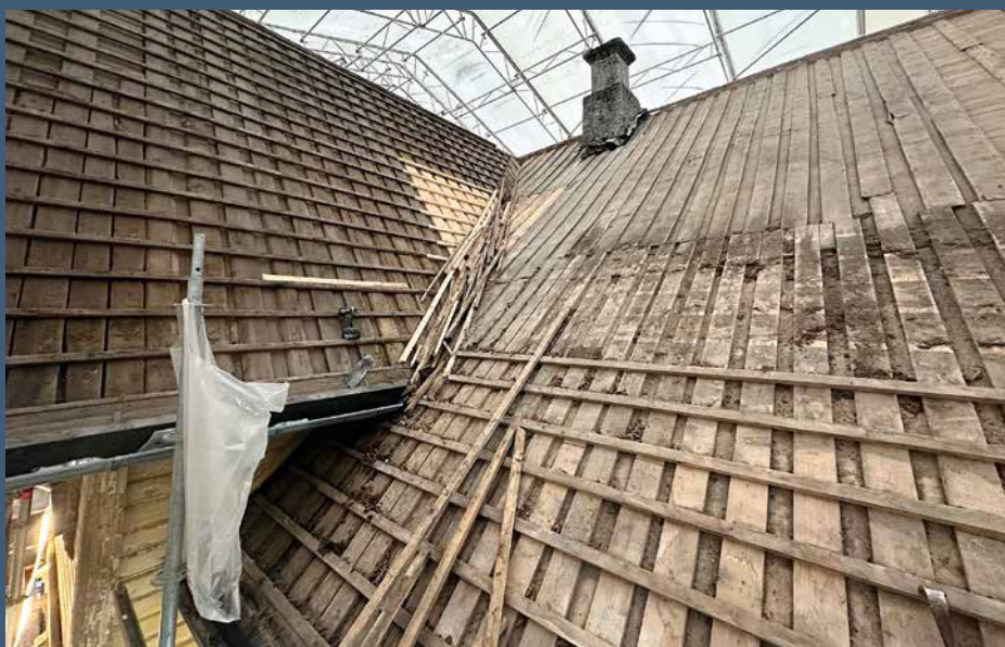
Slik så taket ut etter at skifer og takstein var tatt ned. (Foto: Tom Rune Tjensvoll)
