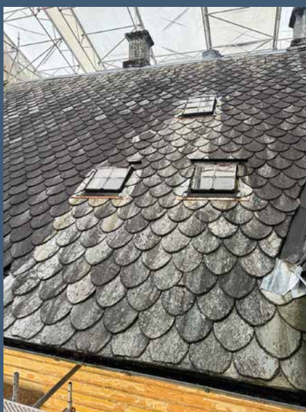
Slik så den gamle skiferen på taket til Nedre Lagårdsvei 2 ut, før den ble tatt ned. Den viste seg å være i for dårlig kvalitet til å kunne gjenbrukes. (Foto: Tom Rune Tjensvoll)
