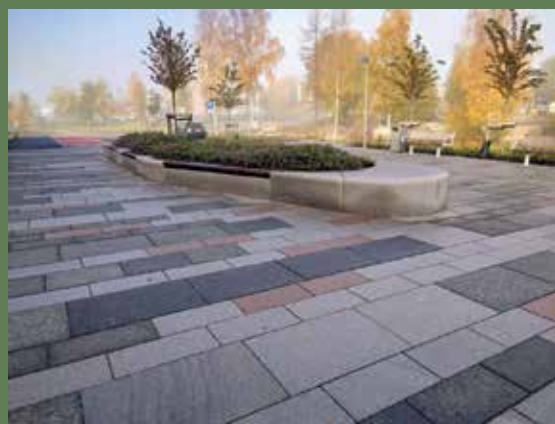
Det er kun benyttet norsk stein – oppdalskifer og Iddefjordgranitt. Den er bygget i en vinkel med to sider og åpner seg ut mot landskapet. Den tilbakelente formen på muren gir god synsvinkel for å lese navneplater. Foto: Birgitte Adal/Asplan Viak
