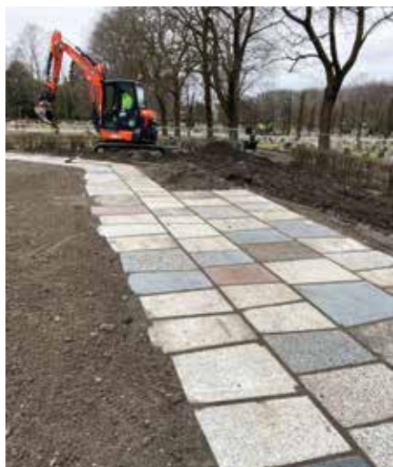
Steinganger under bygging på Østre gravlund. Entreprenør er Skaaret landskap.
