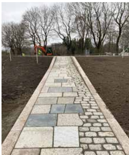
Steinsatt rampe med ombrukte gravminner og storgatestein fra stedet. Vanger av Røykengranitt.
