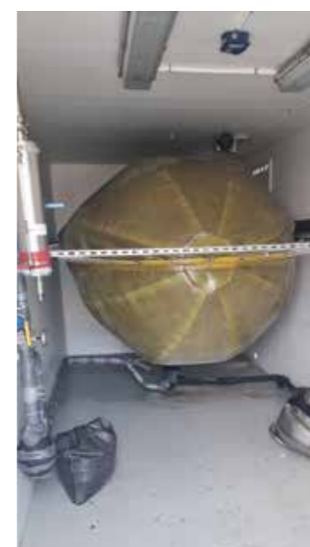
Gassen fra reaktoren samles i denne ballongen.
