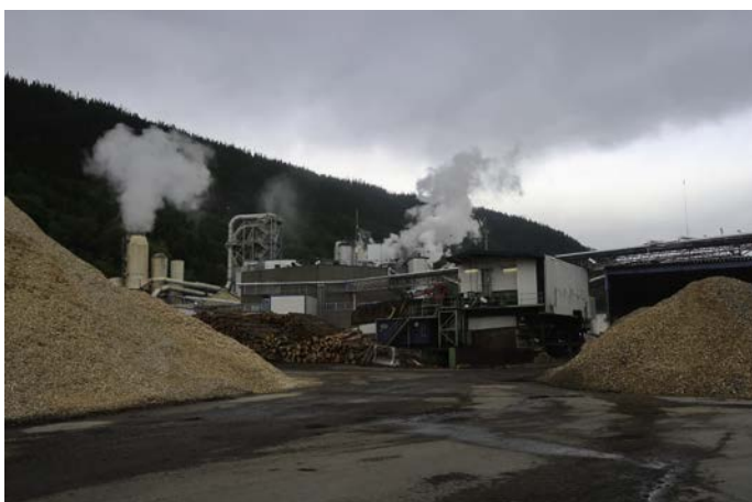
SAGBRUK FØRST: Bruk har det vært på tomten ved Follas utløp i Beitstadfjorden siden 1901. Først sagbruk, siden tresliperi.
