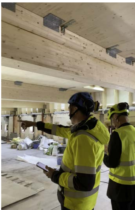
BYGGER: Den 150 år gamle bygningen i Øvre Vollgate 11 i Oslo får to nye etasjer i tre. (Foto: Kristin Vedum, Innotre)
